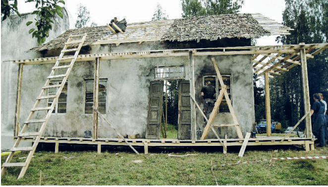
Talo rakenteilla. Muukalainen (2009).
